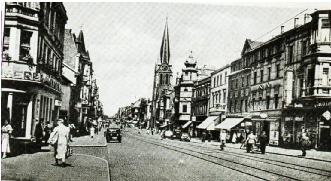
1938 ist die Straße verbreitert. Die Straßenbahn verläuft mit zwei Spuren. Alle Bäume sind verschwunden.
