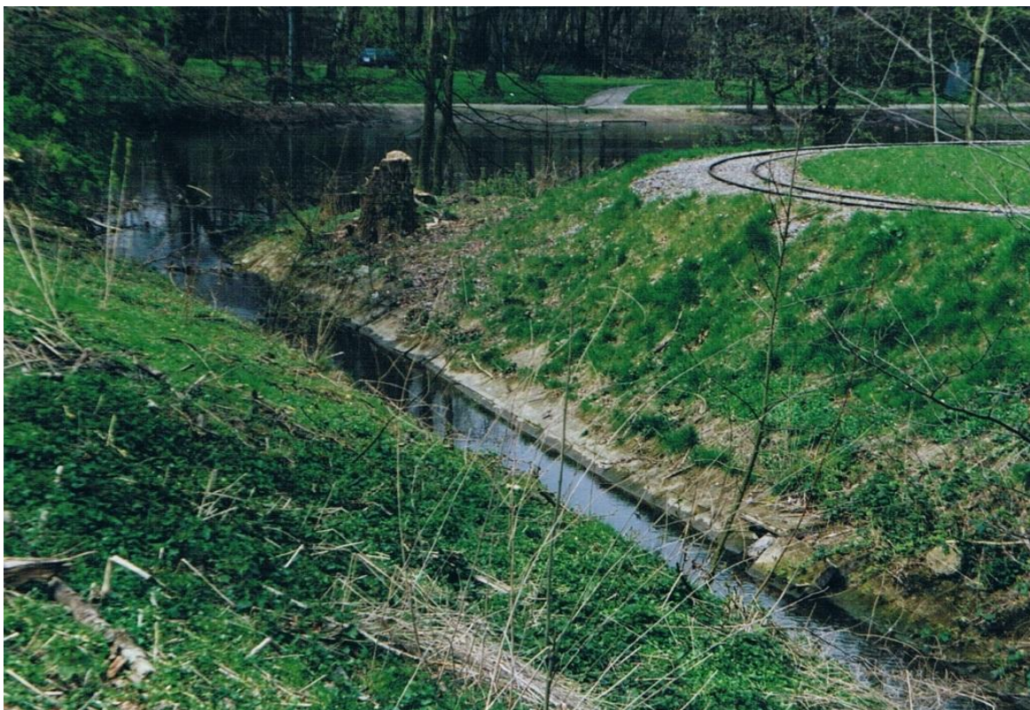
Abb. 9: Noch ist der Ostbach im Bereich vor Einlauf in den Gysenbergteich naturfern ausgebaut.
