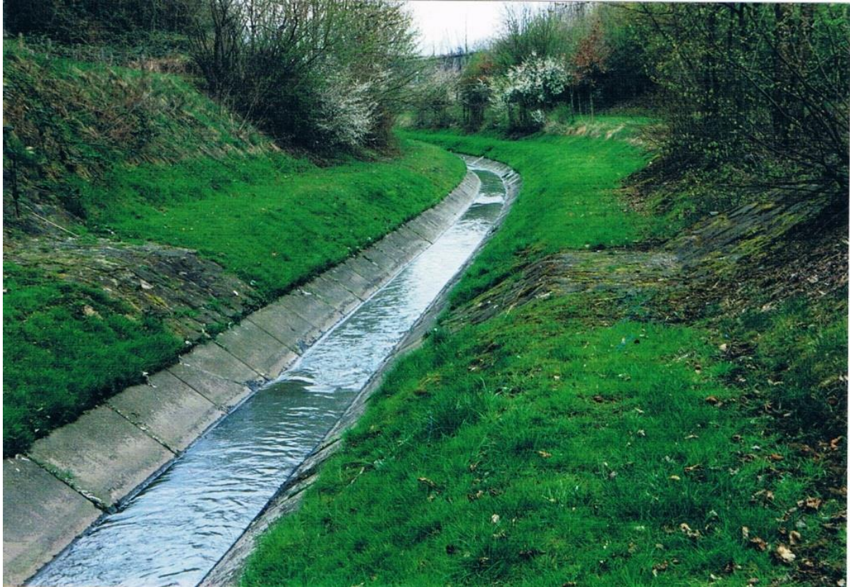
Abb. 1: Der Sodinger Bach (hier im Abschnitt vor Unterquerung der Castroper Straße) ist kanalisiert und dient als reiner Vorfluter der Emscher.
