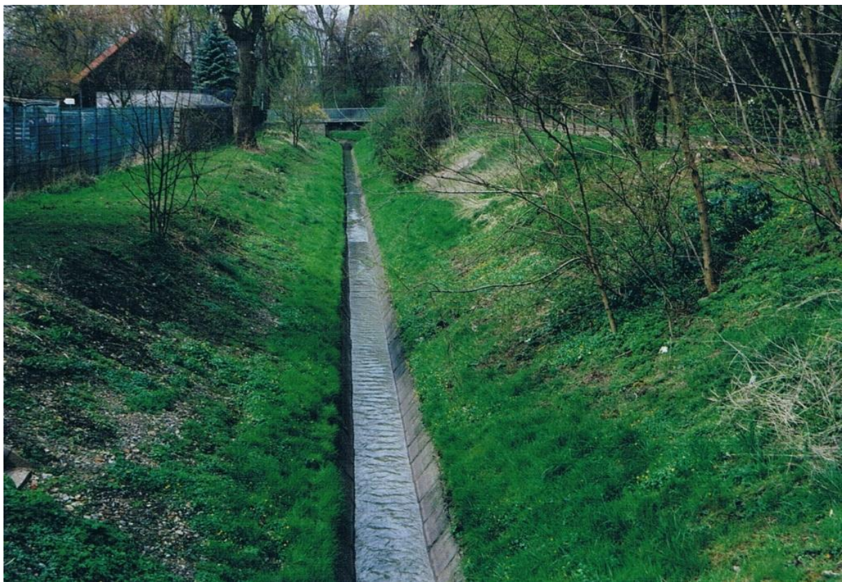
Abb. 10: Auch im Bereich nach Unterquerung der Sodinger Straße ist der Ostbach kanalisiert und mit Emschersohlschalen ausgekleidet.
